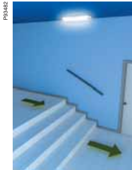
her basamağı aydınlatmak üzere merdivenlerde
